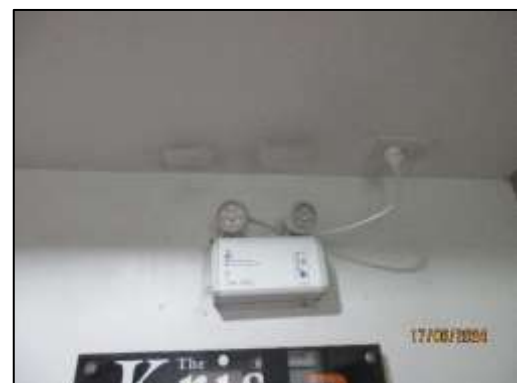
รูปที่ 45 ไฟฉุกเฉิน ระบบไฟสำรองฉุกเฉิน
