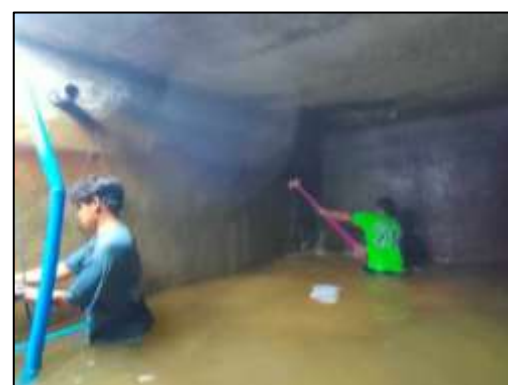
รูปที่ 14 การดูแล ทำความสะอาดถังเก็บน้ำสำรองของโครงการ
