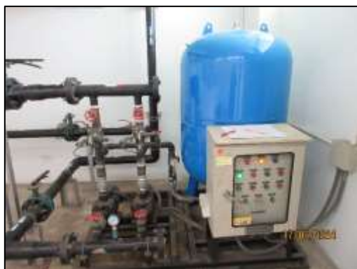
รูปที่ 12 ระบบปั๊มน้ำของโครงการ
