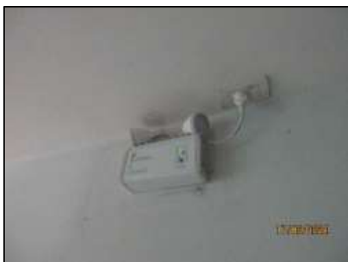
รูปที่ 45 ไฟฉุกเฉิน ระบบไฟสำรองฉุกเฉิน
